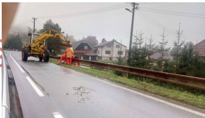
Oprava zvodidiel pred križovatkou
